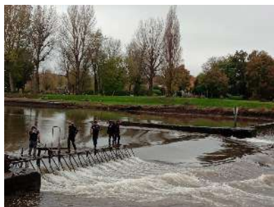
© NEC – Abaissement Bléré
